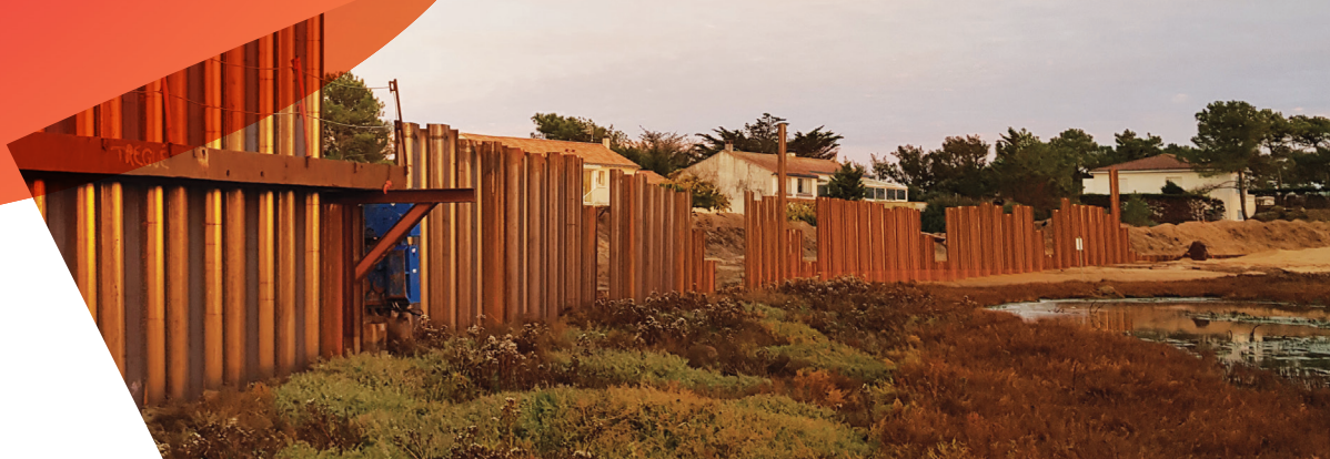
Construction de digue, La Faute-sur-Mer, France © Charier
