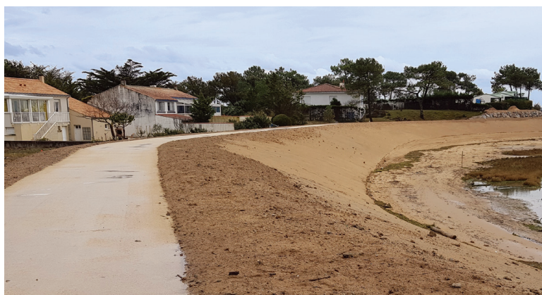
Fin des travaux, La Faute-sur-Mer, France © Charier
